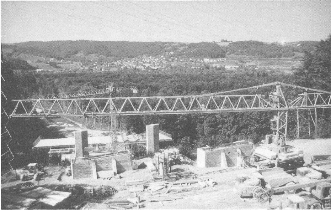
Villnachern mit dem biologisch wertvollen Bözbergsüdhang, von der Baustelle Habsburgtunnel N3 aus gesehen. (1989)
