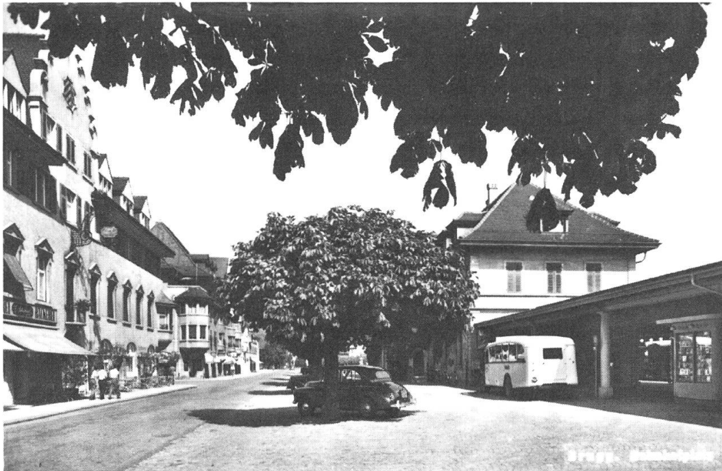
Der Ende der vierziger Jahre noch beinahe verkehrsfreie Brugger Bahnhofplatz. Links die barock-klassizistische Fassade des damaligen Hotels Bahnhof – ein Bau des renommierten «Charlottenburger Fröhlich».
