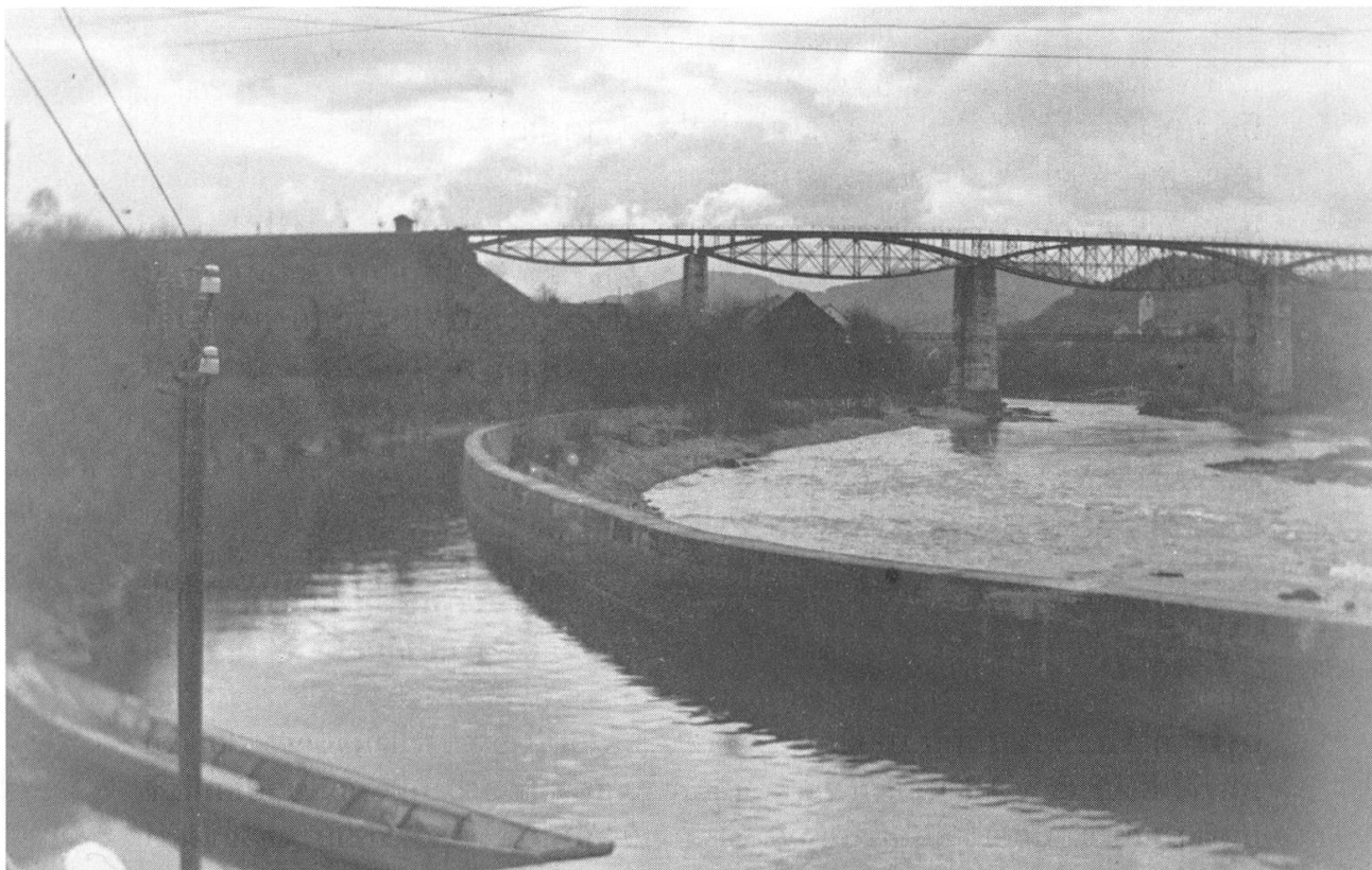
Die Altenburger Eisenbahnbrücke mit Oberwasserkanal.
