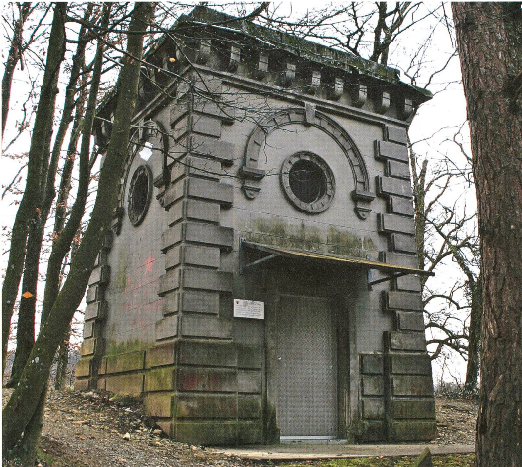
März 2008 – Das alte Windischer Wasserreservoir «Chapf» mit einem Speichervolumen von 1900 Kubikmeter soll ersetzt und auf 3000 Kubikmeter erweitert werden. Foto Peter Belart, «Aargauer Zeitung»
