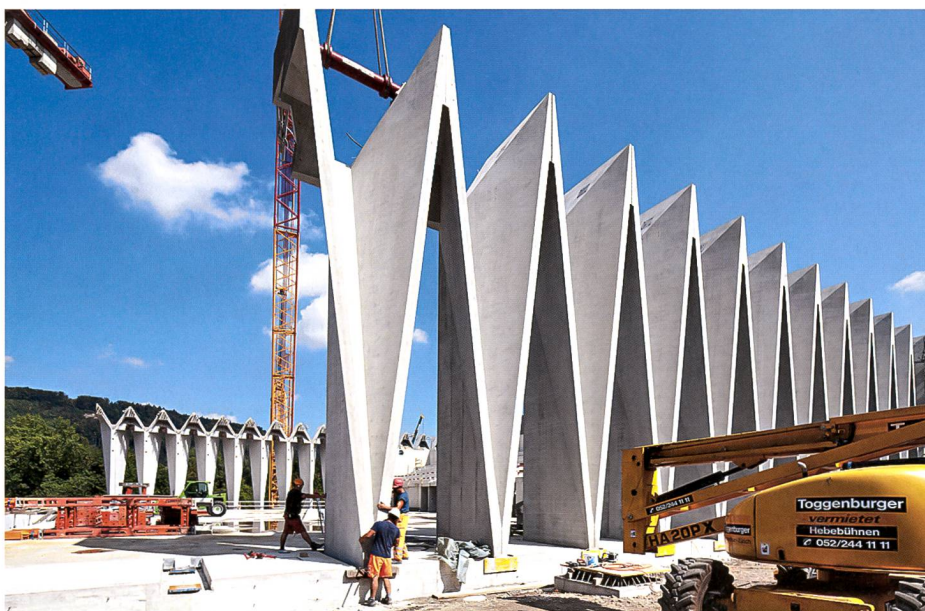
Die Versetzung der Fassadenelemente
