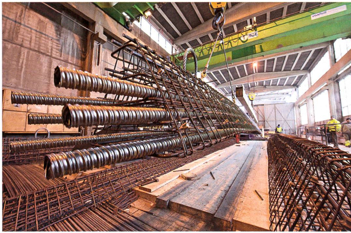
Produktion der Armierung für die Dachträger
