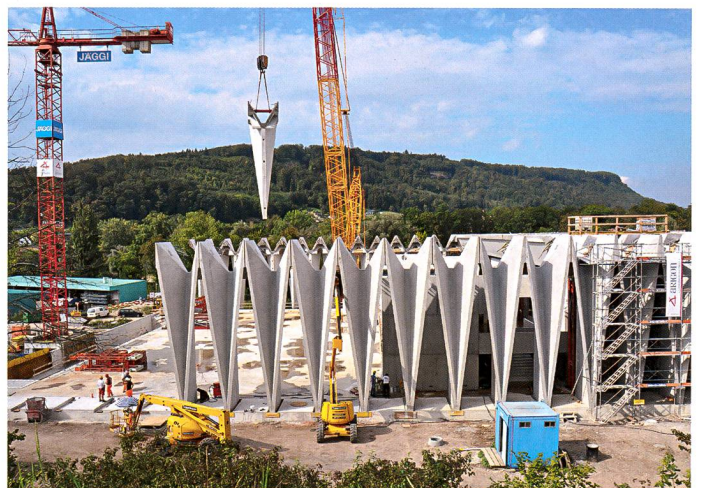
Der 500-Tonnen-Raupenkran platziert Betonelemente bis zu 50 Tonnen
