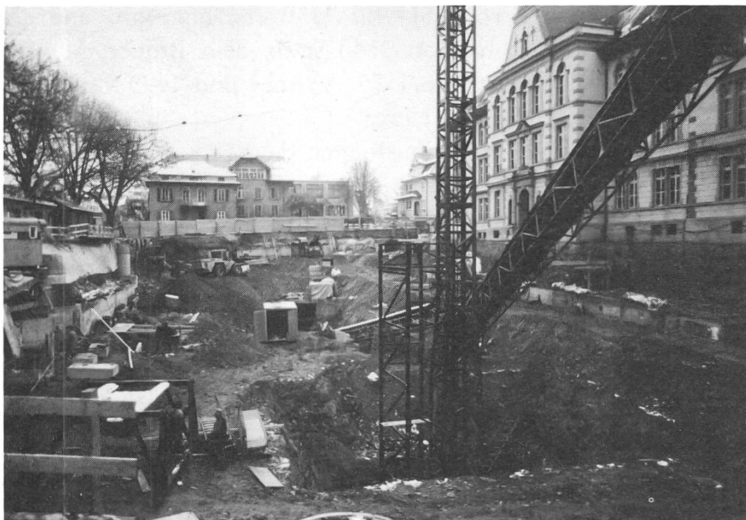
Vor 15 Jahren . . . Baustelle für Parkhaus Obertor 1985
