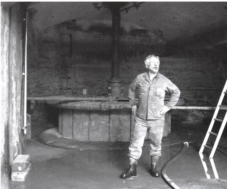
Renovation der Francisturbine. Albert Süess im trockengelegten Turbinenschacht.
