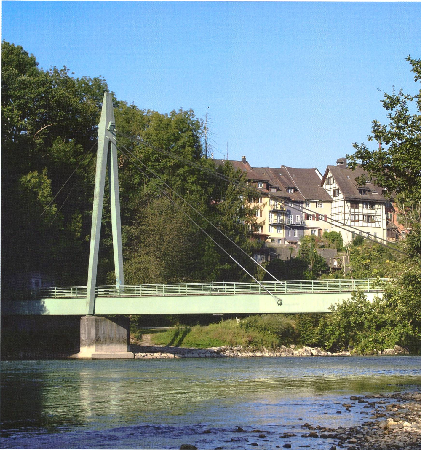
Die Schrägseil- hängebrücke.
