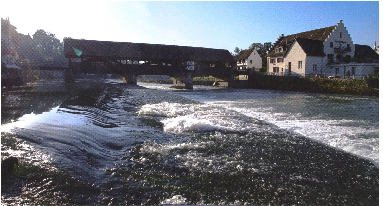
Die gedeckte Holzbrücke.
