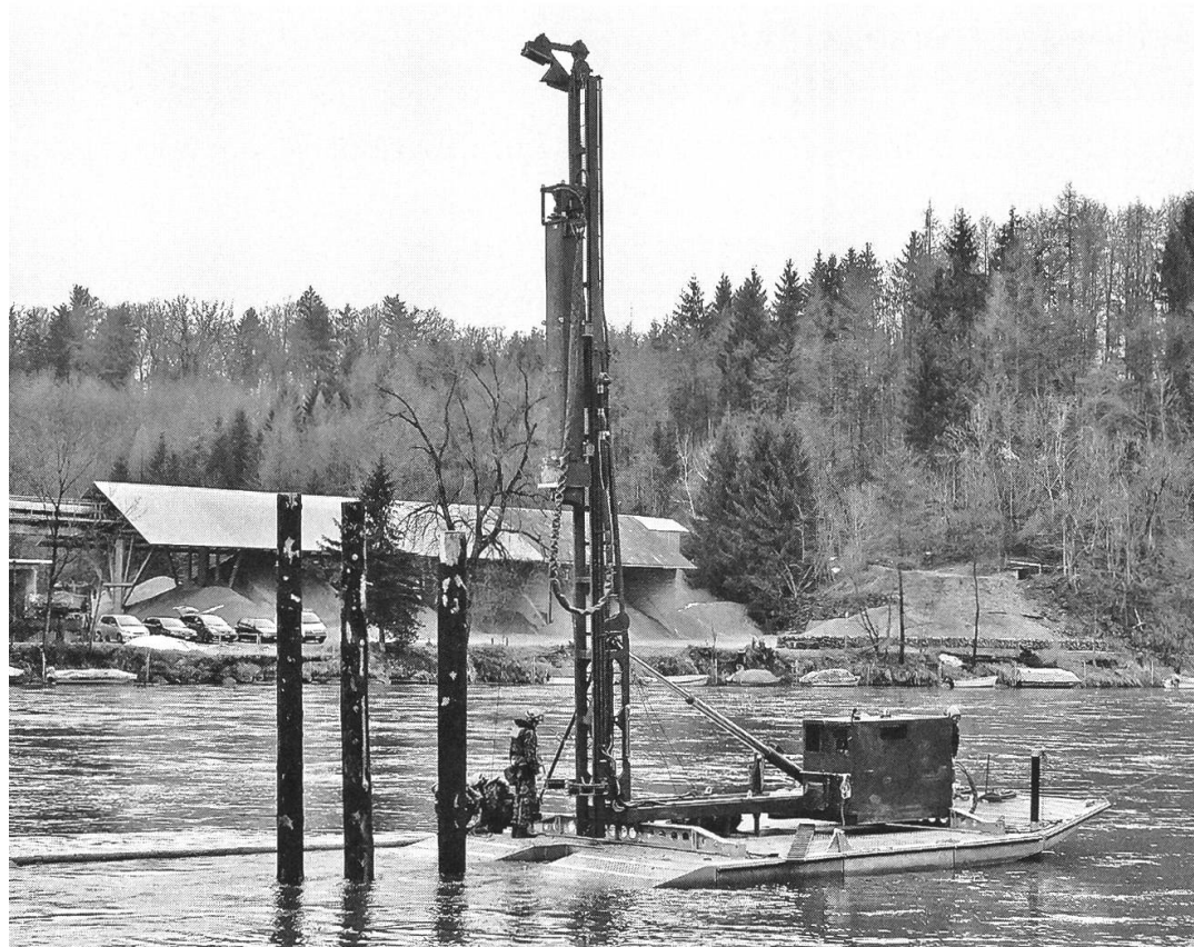
Einsatz Pfalhrammgerät.
