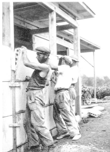
**Bau des Villiger-Hauses 1942.** Bauarbeiter montieren die Fertigbau-Elemente der Firma Durisol.
