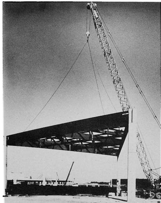
Bild 11: Montage eines dreieckförmigen Trägerfeldes von 28 m Seitenlänge mittels Autokran
