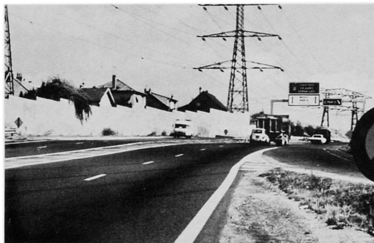
Ecran absorbant réalisé le long de la déviation de la RN 188 à Champlan (Essonne)
