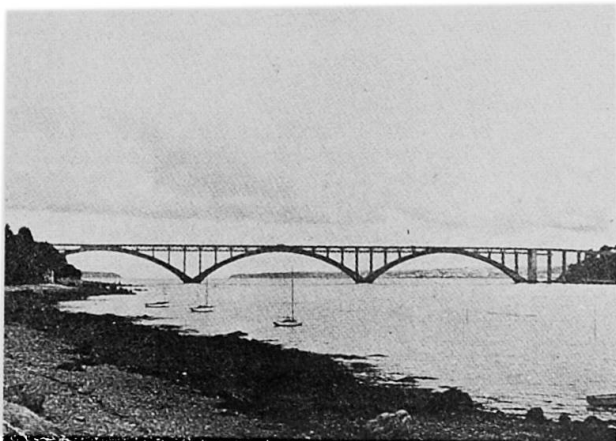
Fig. 17 - Pont de PLOUGASTEL (portée 186 m)
