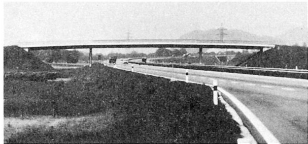
Bild 8 Inntalautobahn Objekt M 42 – Ueberf. einer Gmd.Strasse (1968)
