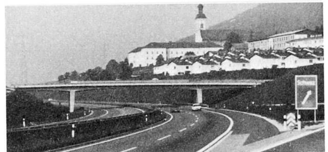
Bild 5 Inntalautobahn Kreuzungsbauwerk Schwarz (1968)
