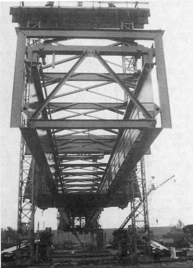
Bild 2 Stahlkonzeption für den Hauptträger
