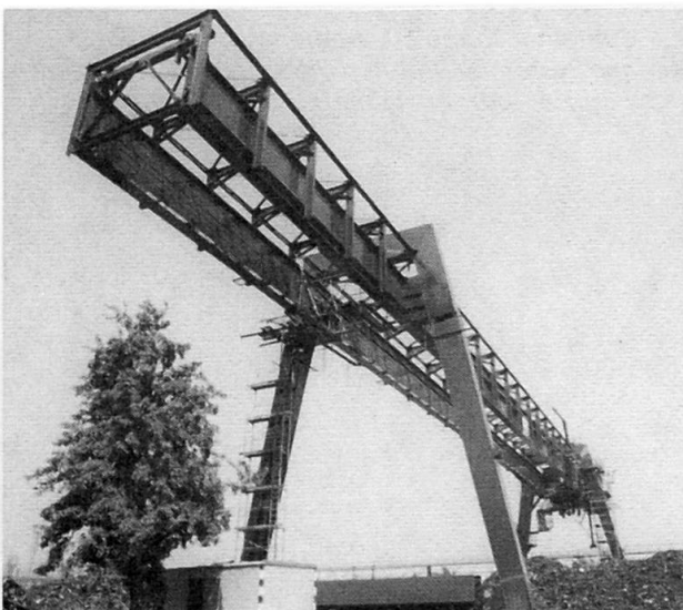
Bild 1 Gesamtansicht der Brücke
