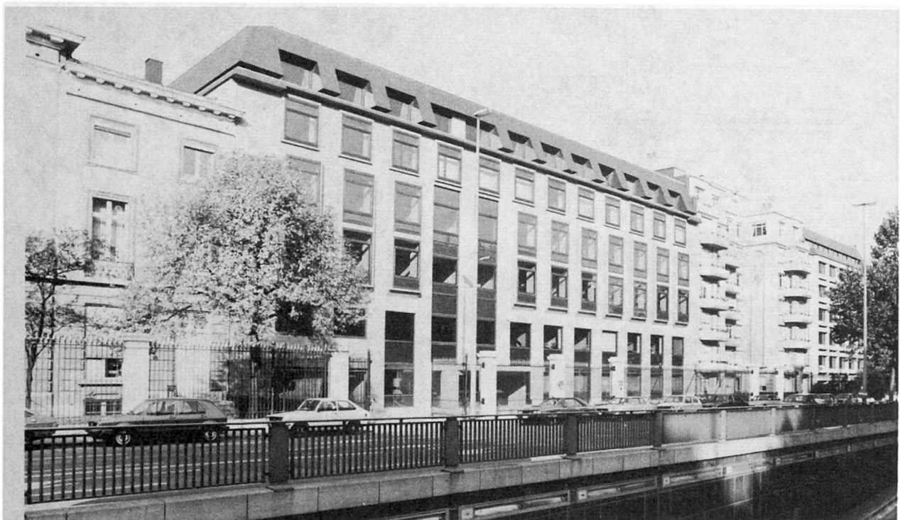
Vue du centre administratif
