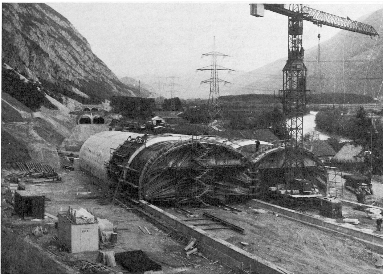
Bild 3 Tunnel mit Kriechspur
