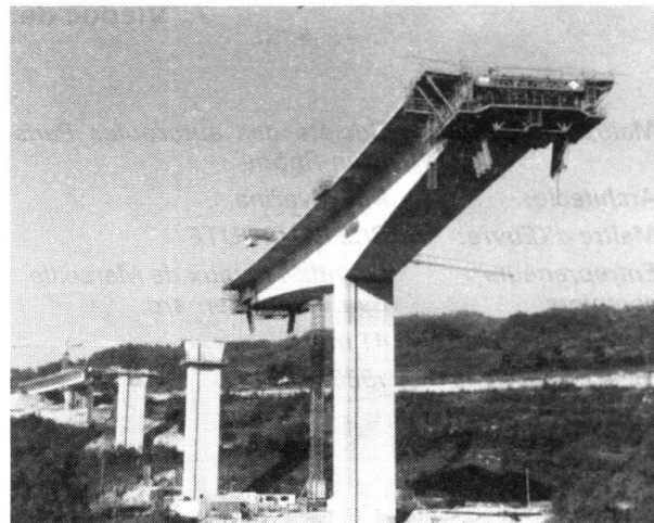
Ouvrage en cours de construction
