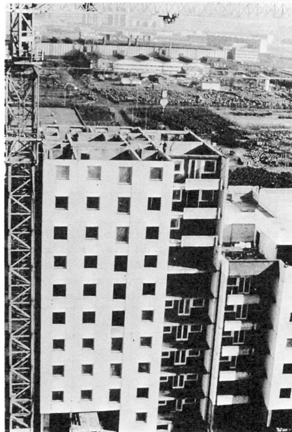
Fig.21 Le montage, vue générale
