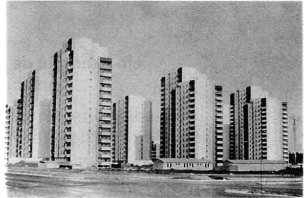
Fig. 1. Ensemble de la première tranche de travaux.
