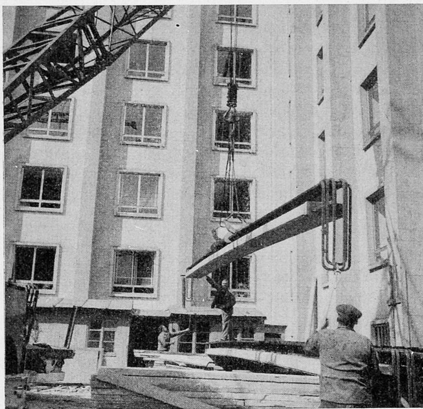
Fig. 4 - *Complexe Administratif, rue de Louvain à Bruxelles*. Poutres Preflex de 13,50 m avec aux extrémités des barres d'armature soudées à la poutrelle et servant à l'encastrement des poutres Préflex dans les colonnes.
