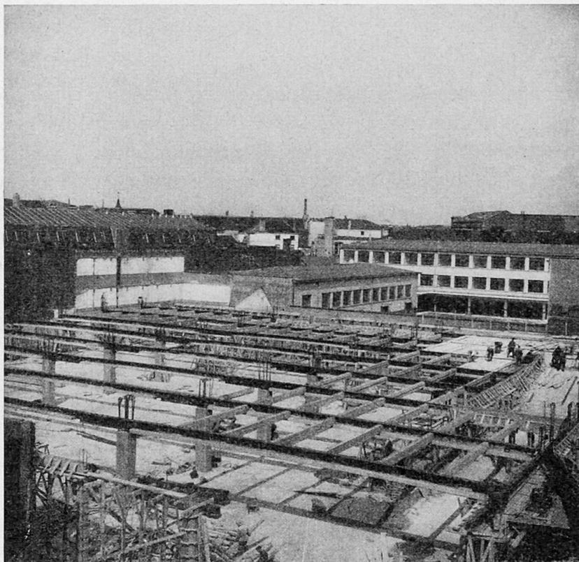
Fig. 1 - *Grand Garage du Vieux Marché aux Grains à Bruxelles*. Mise en place des poutres secondaires préfabriquées en béton armé sur les semelles des poutres Préflex de 20 m. Les coffrages de la dalle coulée sur place, s'appuyent sur les poutres secondaires de 6,60 m.
