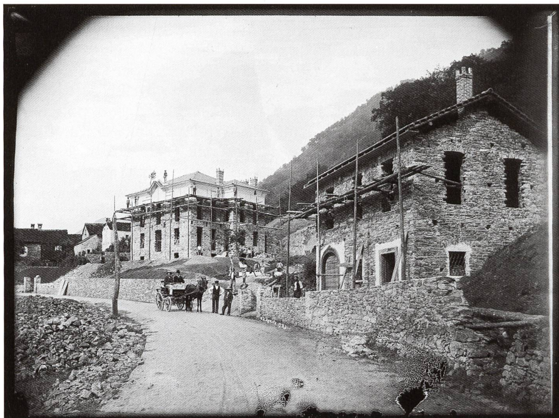
Stato dei lavori di costruzione di villa Peri il 28 agosto 1893. Fotografia di Angelo Monotti (ASTi, Angelo e Valentino Monotti L 29/3).
