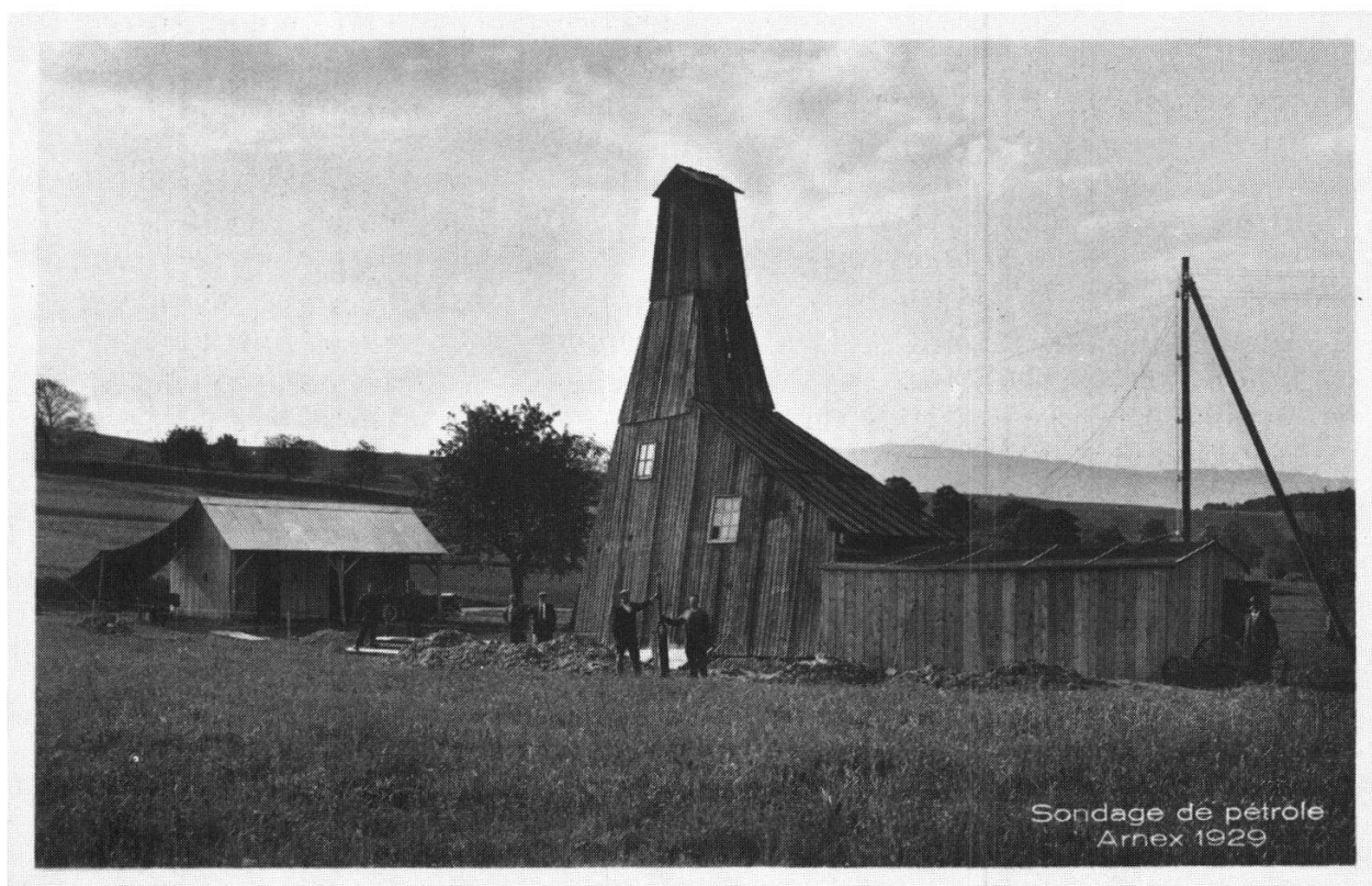
Figure 5.—Sondage Arnex-1 en 1929, à Pré Bertrand. Vue des installations de surface; les deux personnages au centre tiennent un trépan de la foreuse à balancier. Photo Marcel Deriaz, Vallorbe. Collection Pierre Decollogny, Orbe.
