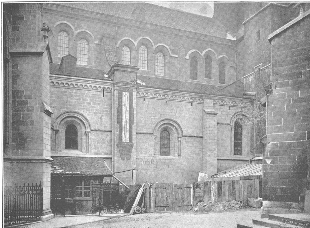
NEF ET BAS-COTÉ SUD AVANT LES TRAVAUX DE RESTAURATION
