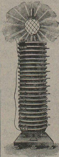
Economie de place 75 % et même davantage. Transport facile et sans risque. Montage et démontage très simples, exécutables par n'importe quel ouvrier. Diminution de la longueur des câbles du réducteur. Suppression de la casse des récipients et des mauvais contacts. Absence de déformation des électrodes, par conséquent diminution notable des risques de court-circuit. Suppression des connexions intermédiaires. Isolation très simple et absolue.
