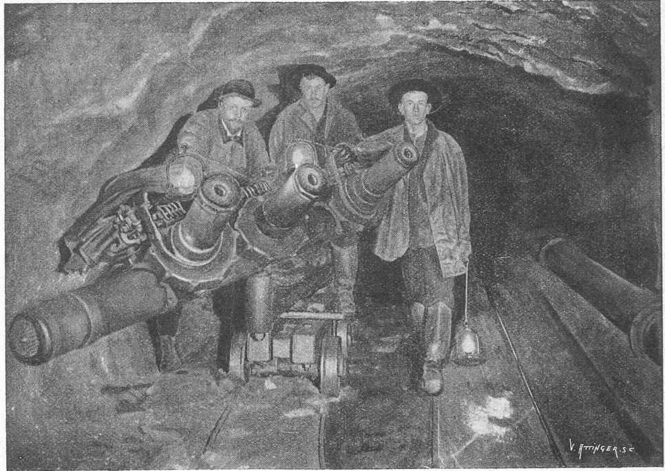
Fig. 6. — Le tunnel près de « l'avancement ». Perforatrice au repos.
