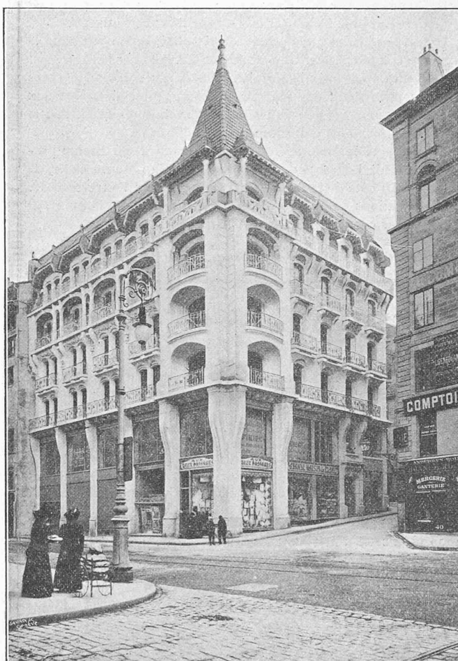
Immeuble construit par M. Eug. Corte, architecte.
