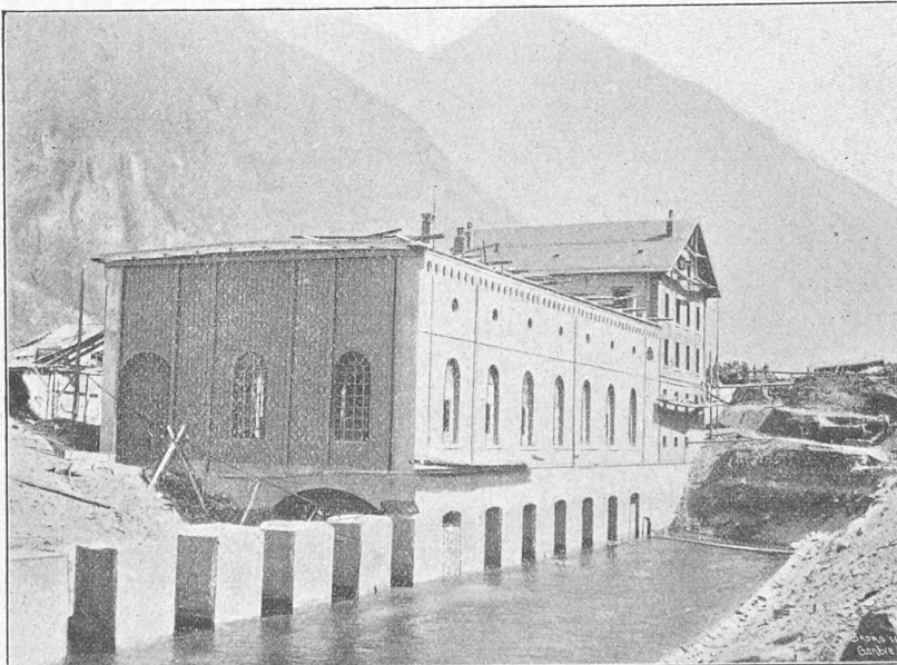
Fig. 5. — Le bâtiment des turbines.
