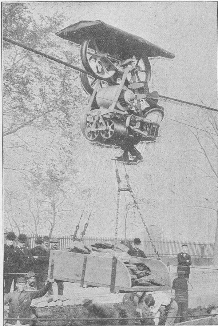
Fig. 8. — Blondin électrique. Détail du chariot.
