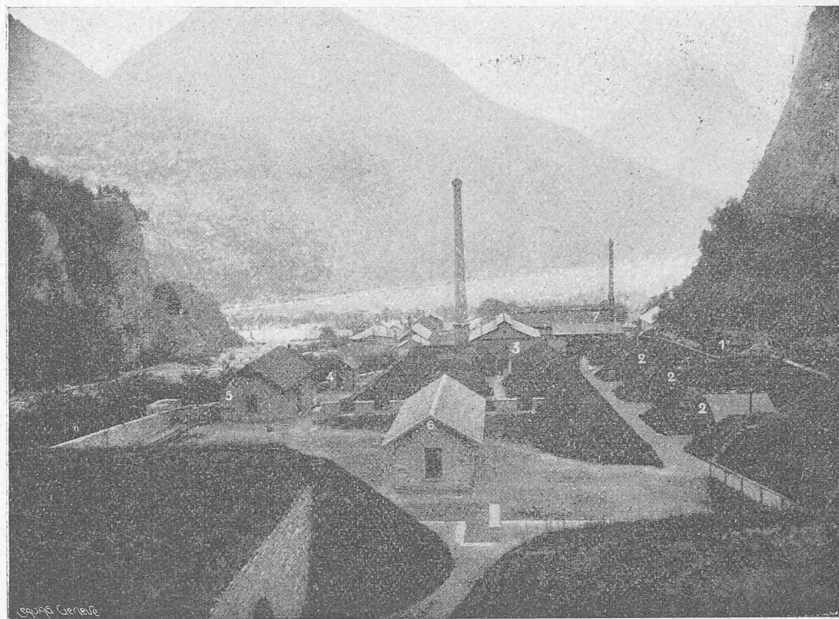
Fig. 2. — Vue générale de l'Usine.
