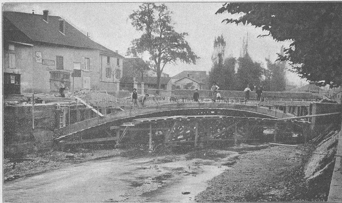
Fig. 6. — Pont de Jallieu (Isère). — Vue prise pendant la construction.
