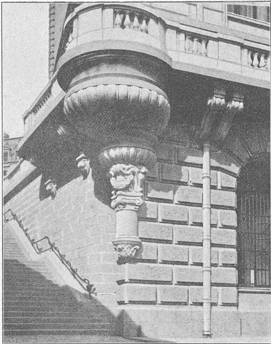
Fig. 8. — Encorbellement et cul-de-lampe en granit à l'angle du balcon de ronde.
