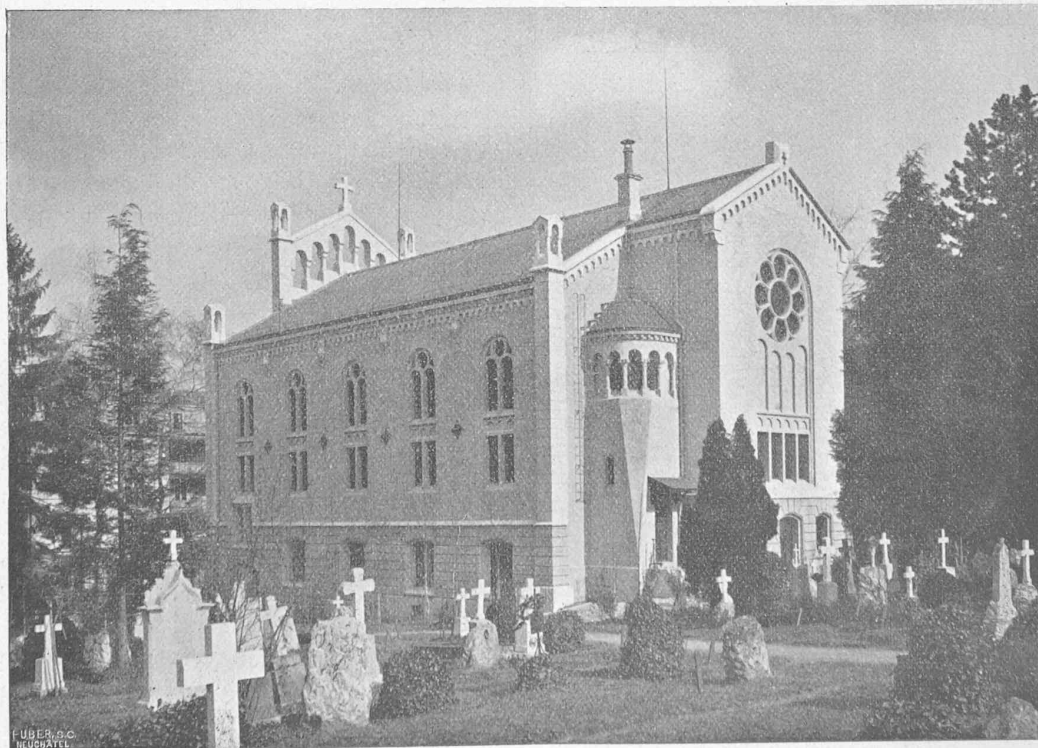
Fig. 1. — La nouvelle église française de Zurich. — Vue d'ensemble. Façade latérale et postérieure.
