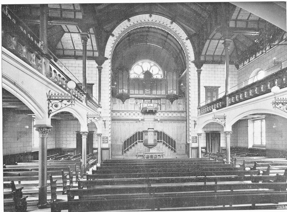
LA NOUVELLE ÉGLISE FRANÇAISE DE ZÜRICH. — VUE INTÉRIEURE GÉNÉRALE.
