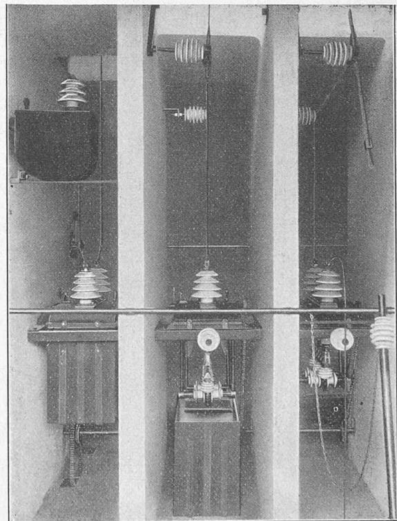
Fig. 9. — Vue de face des interrupteurs automatiques.
