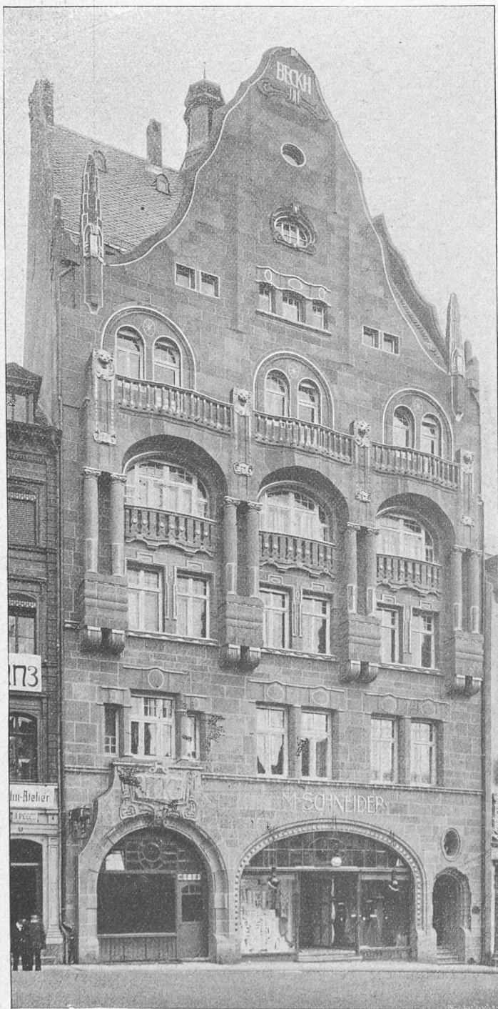
Fig. 13. — Maison d'habitation et brasserie de MM. Beckh frères, à Pforzheim. Architectes : Prof. H. Billing et E. Maler, à Pforzheim.
