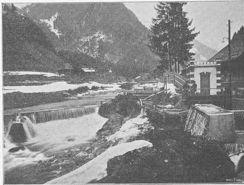
Fig. 2. — Barrage supérieur de l'Usine de Charmey, sur la Jogne.
