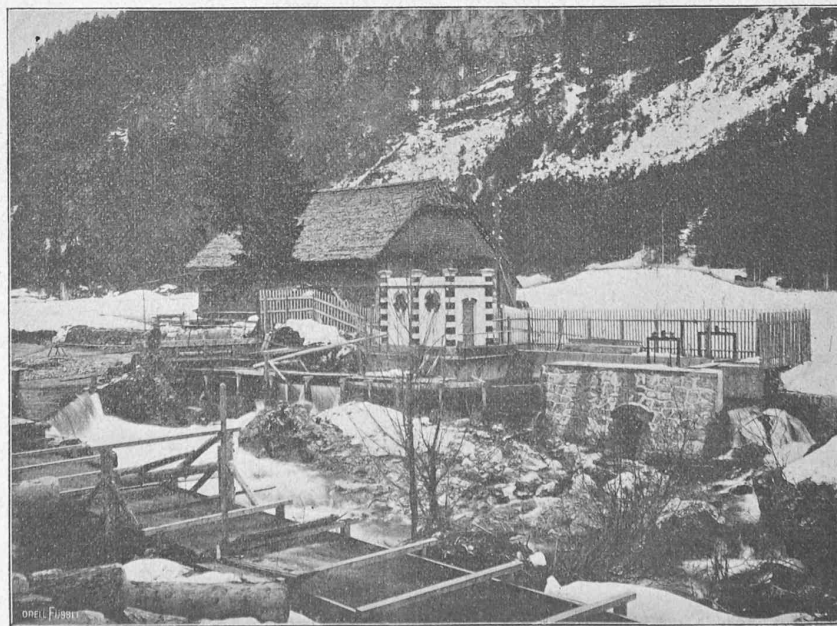
Fig. 3. — Barrage supérieur de l'Usine de Charmey, sur la Jogne.
