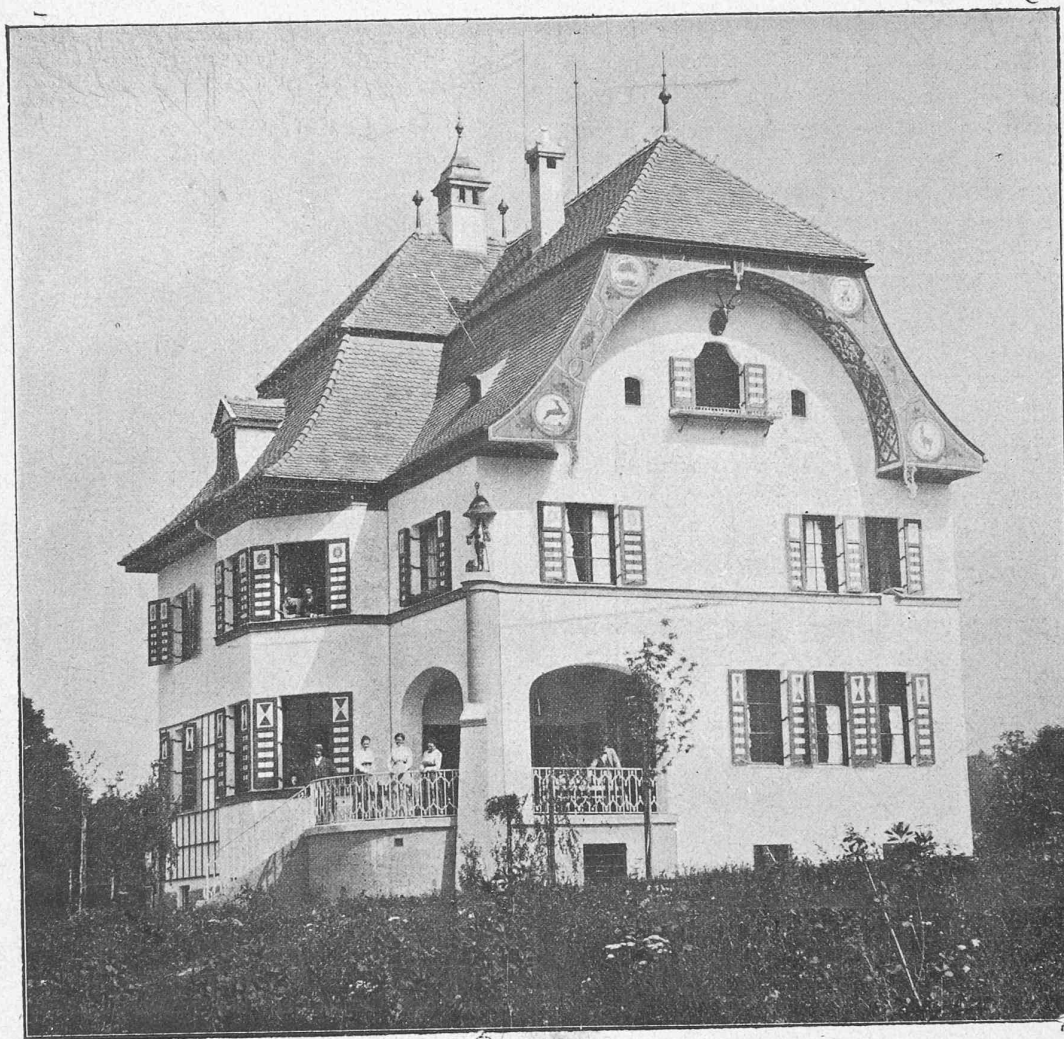
Fig. 39. — Façades Ouest et Sud.
