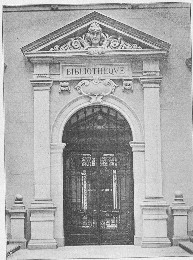
Fig. 19. — Portes latérales de l'Atrium (corps central).
