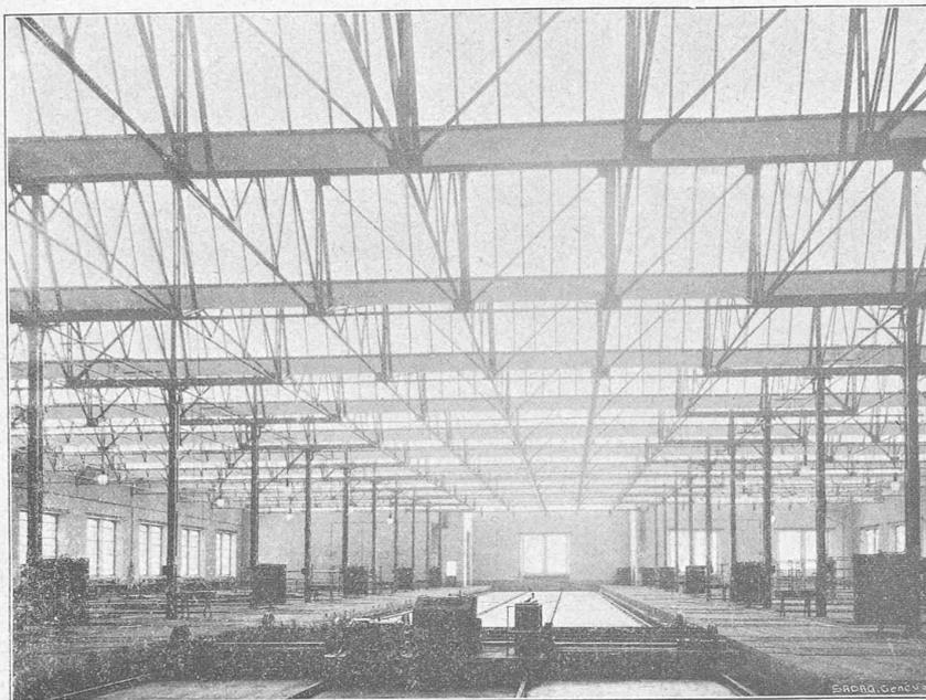
Fig. 12. — Halle de montage des locomotives avec chariot transbordeur.
