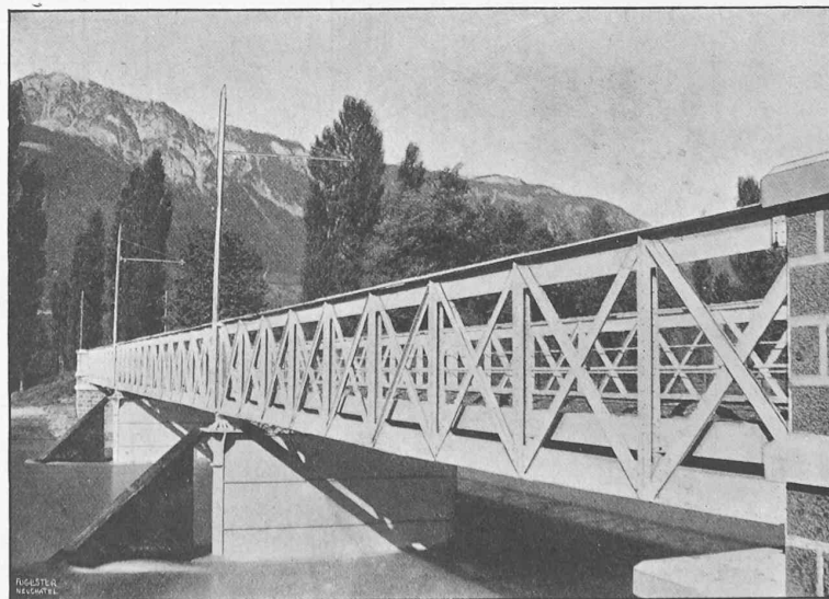
Fig. 3. — Vue d'ensemble du nouveau pont.
