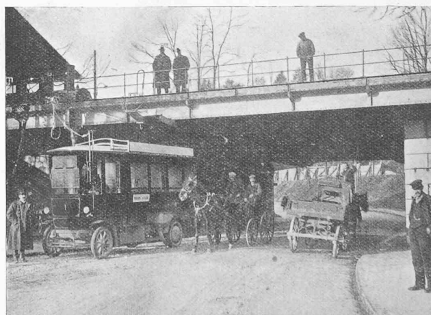
Fig. 1. — Passage sous le pont de Romont des C. F. F. (Gare de Fribourg).
