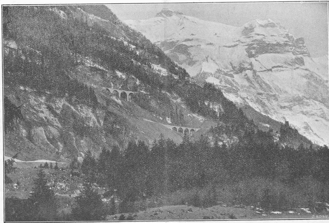
Fig. 1 — En bas, à gauche, entrée du tunnel de Fürten; à mi-hauteur, viaduc de Fürten; en haut, viaduc de Ronenwald.
