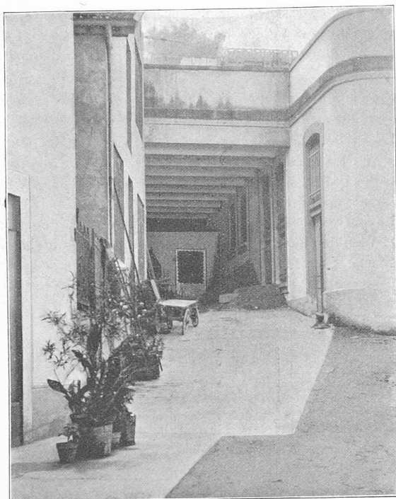
Fig. 17. — En tunnel sous l'immeuble Lagrange et le bâtiment de la manutention — dessus de la dalle fer et béton.
