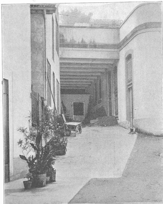
Fig. 17. — En tunnel sous l'immeuble Lagrange et le bâtiment de la manutention — dessus de la dalle fer et béton.
