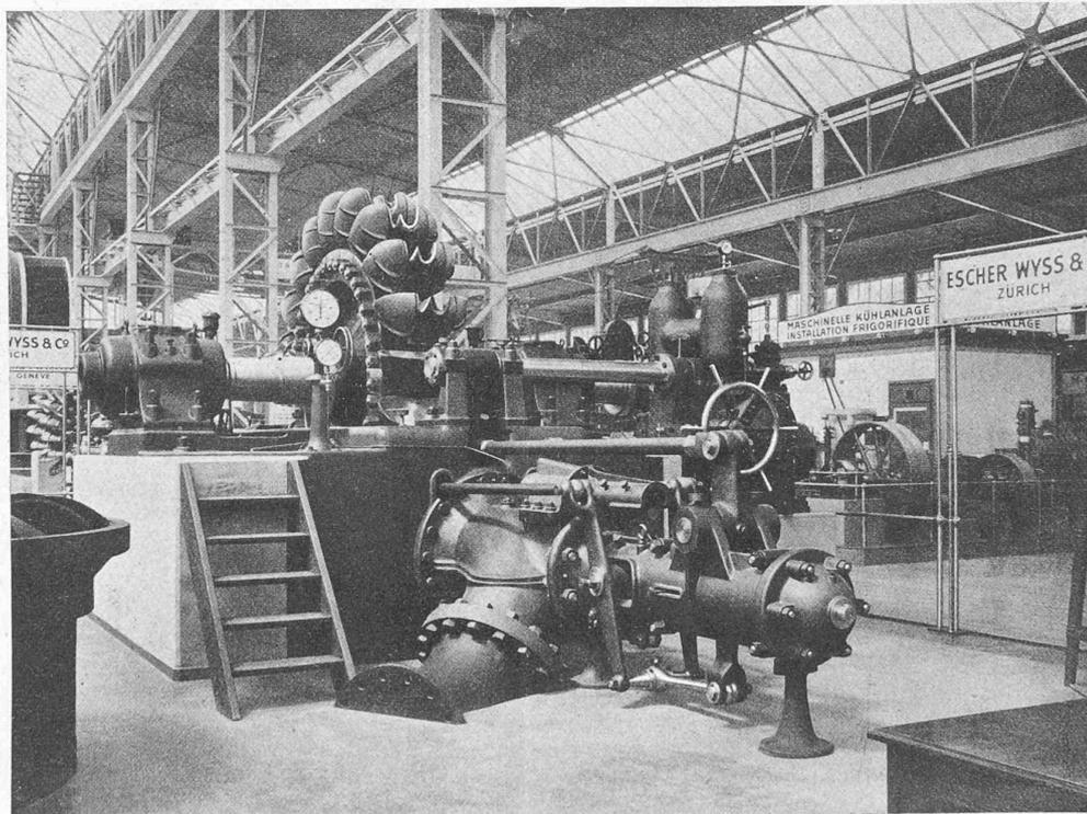
Fig. 2. — Turbine Pelton destinée à l'Usine de la Borgne.
