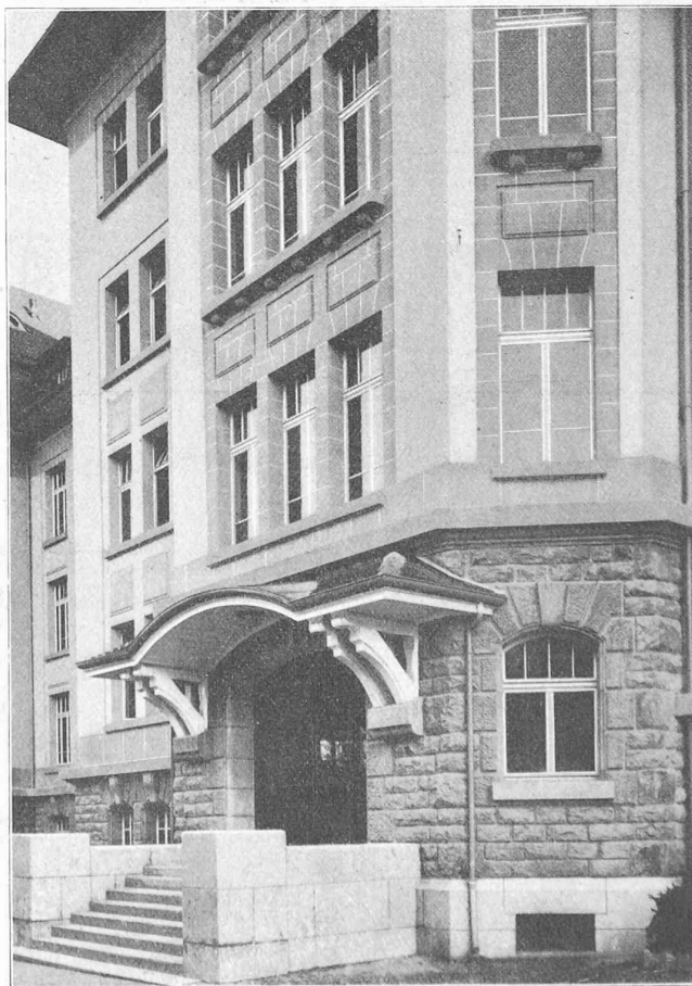
Motif central de la façade nord.
