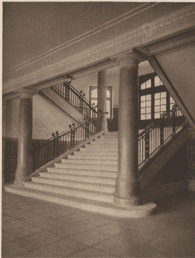
DÉPART DE L'ESCALIER PRINCIPAL
