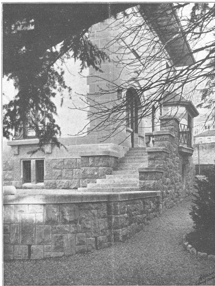
Détail de la façade Est.
