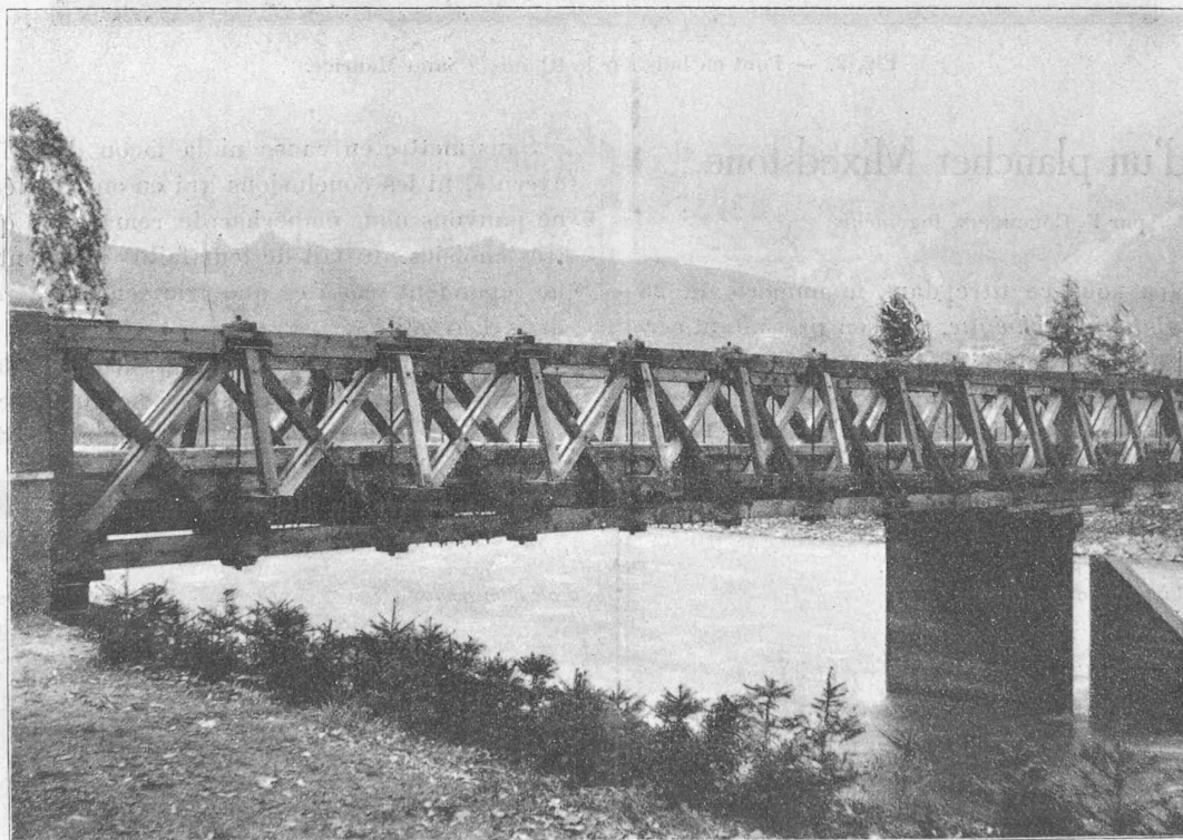
Fig. 1. — Pont en bois sur le Rhône, à Saint-Maurice.
