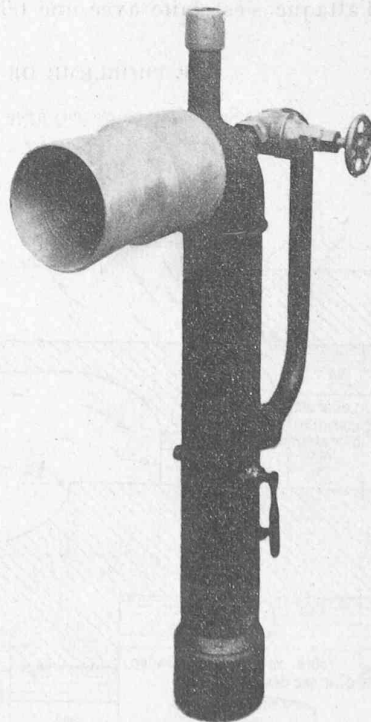
Fig. 3. — Brûleur Reverber pulver type 30 kg. de charbon à l'heure.
