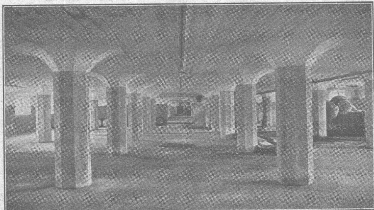
Plancher sans nervures, système Maillart. — Sous-sol d'entrepôt.
