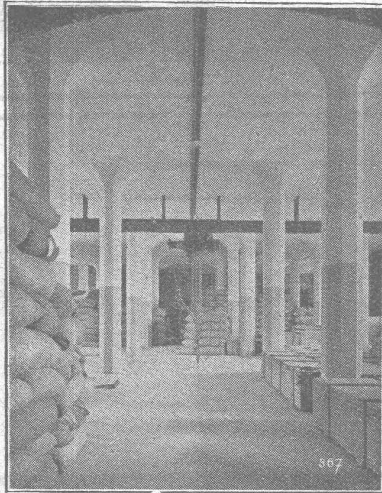
Rez-de-chaussée d'un Entrepôt, à Zurich
